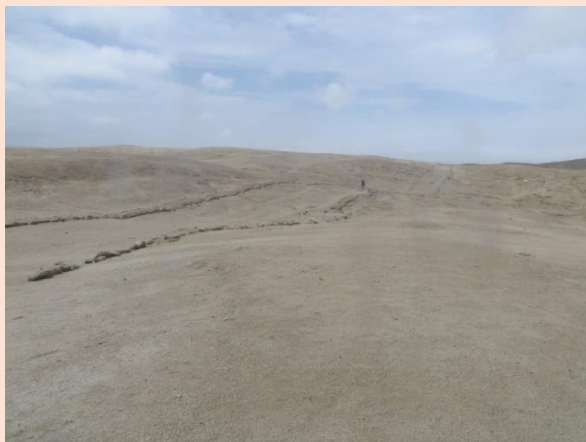
Imagen 7. Segmento del camino con muros laterales que se adapta a un terreno sinuoso en el sector de Pampa Antival.
